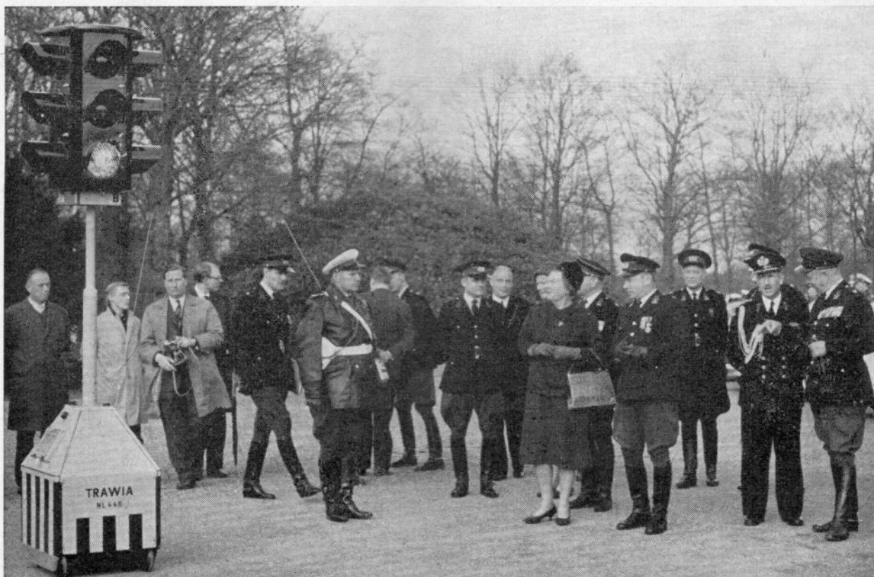
Tot de speciale apparatuur die voor de Koningin werden gedemonstreerd behoorde onder meer een verplaatsbaar radiografisch te bedienen verkeerslicht.
